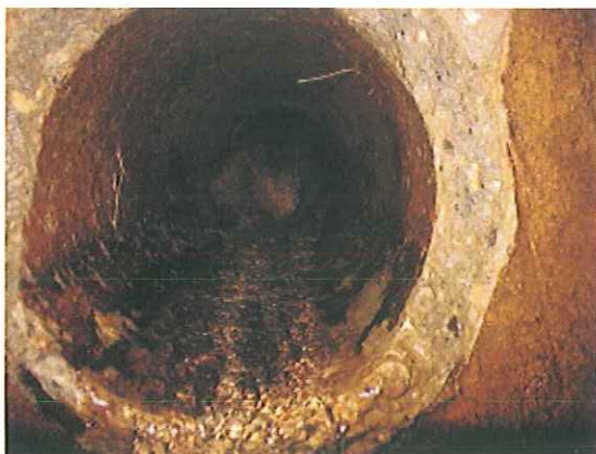
Vue depuis le regard n°1 du drain de la Bonnarde (2 m/TN)
