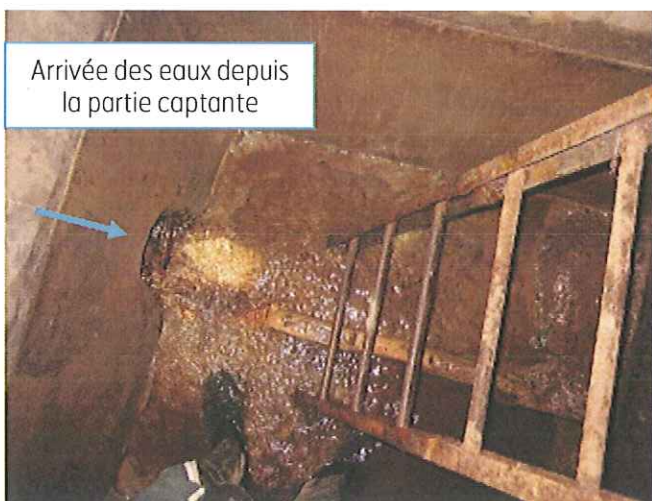
Vue depuis le regard n°5 des 2 drains de la source de Juffet
