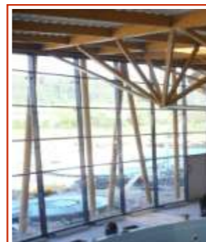
Transparence : Les Métalleries du Forez terminent la pose des vitrages isolants de la façade côté bassins : les grands formats pèsent plus de 200kg les « petits » plus de 100kg.
