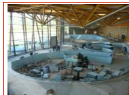
Bleus de Pologne: ce sont des ouvriers polonais qui montent les bassins. (Vue d'ensemble des bassins)
