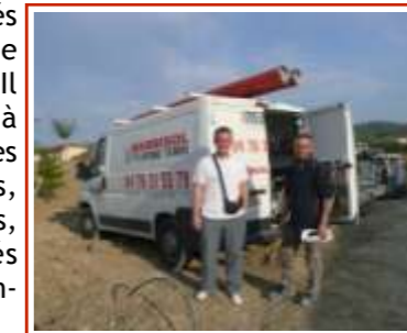
Toile tendue : 20 avril l'entreprise Barrisol de Meyzieu arrive sur le chantier : MM Humbert et Gret installent les plots de fixation prennent les mesures précises de la toile qui sera fabriquée pour être posée fin avril.
