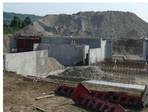
Les murs des zones techniques souterraines et des bacs tampons sont érigés.
